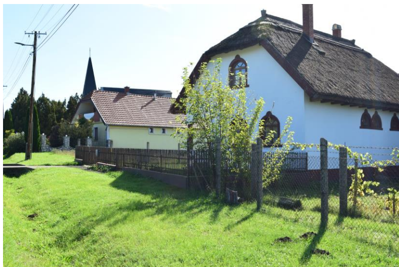
A Jász utca részlete felújított lakóházakkal és a templomtoronnyal
