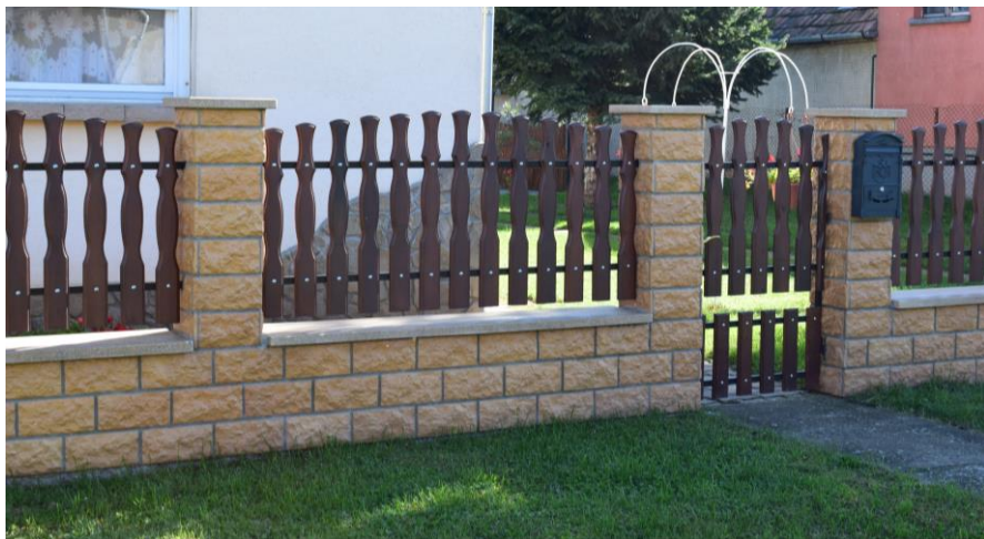
Áttört jellegű kerítés: lábazattal, falazott kerítéspillérekkel, deszkabetéttel
